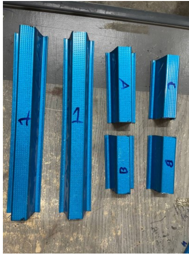
Rajah 1: Pemotongan Battern mengikut saiz
