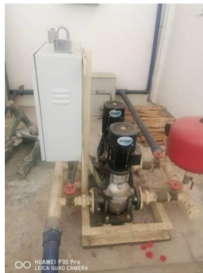
Rajah 16 – 19 : Sistem siraman dan pam air
