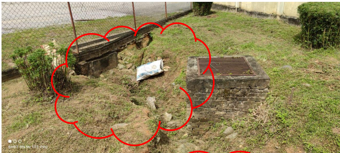
Rajah 14 : Konkrit beam pagar yang perlu dibaiki
