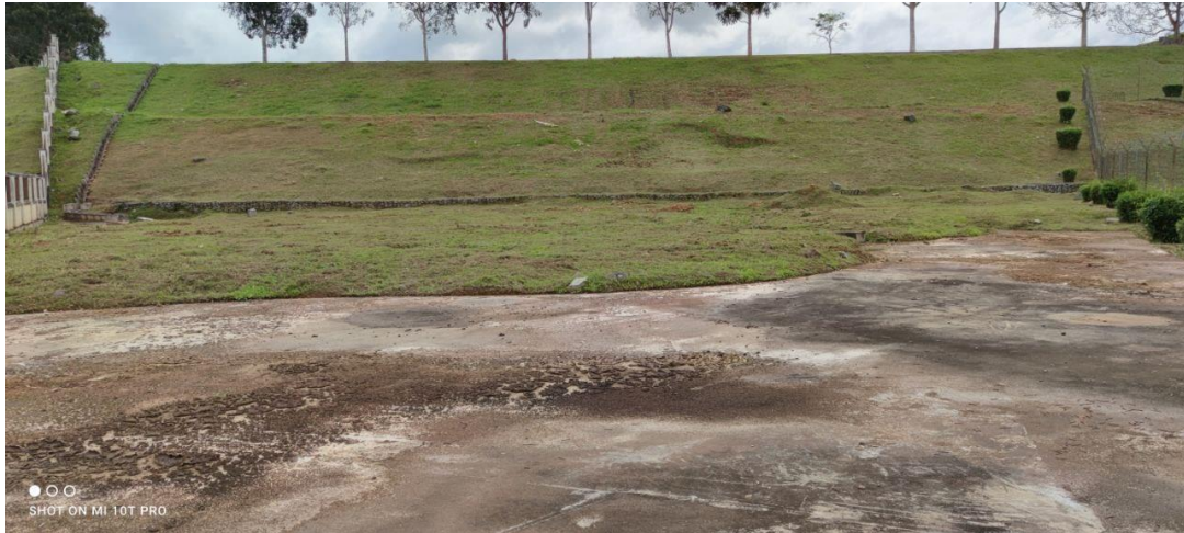
Rajah 11 : Keadaan semasa di atas kolam takungan
