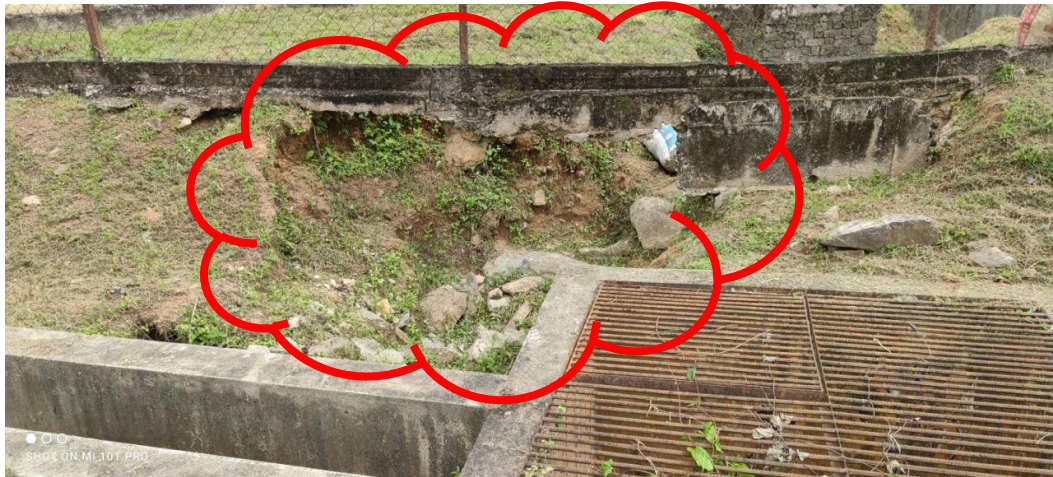
Rajah 14 : Konkrit beam pagar yang perlu dibaiki
