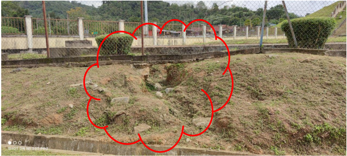
Rajah 15 – 17 : Penyelenggaraan hakisan tanah
