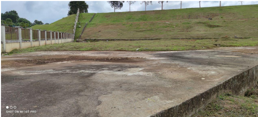
Rajah 12 : Keadaan semasa di atas kolam takungan
