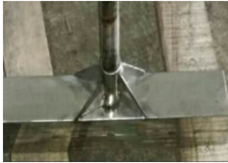
Rajah 3.10 Proses memasang ( braket ) untuk menanggung beban shaf
